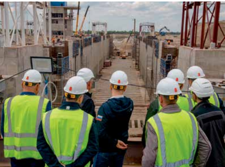
Багаевский гидроузел / Фото Минтранс РФ
