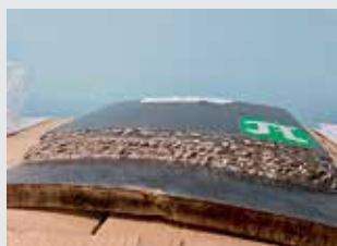
Подводная мокрая сварка трубной стали толщиной больше 20 мм внахлест самозащитной порошковой проволокой. Метод использовался для ремонта разрывов газопроводов, пострадавших от взрыва, но пока не принят Регистром
