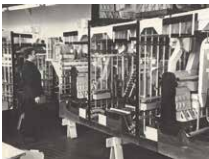
Макет машинного отделения парома, использовавшийся для отработки проектных решений. Эта технология использовалась до появления САПР / Фото из архива КБ ОСК «Вымпел»
